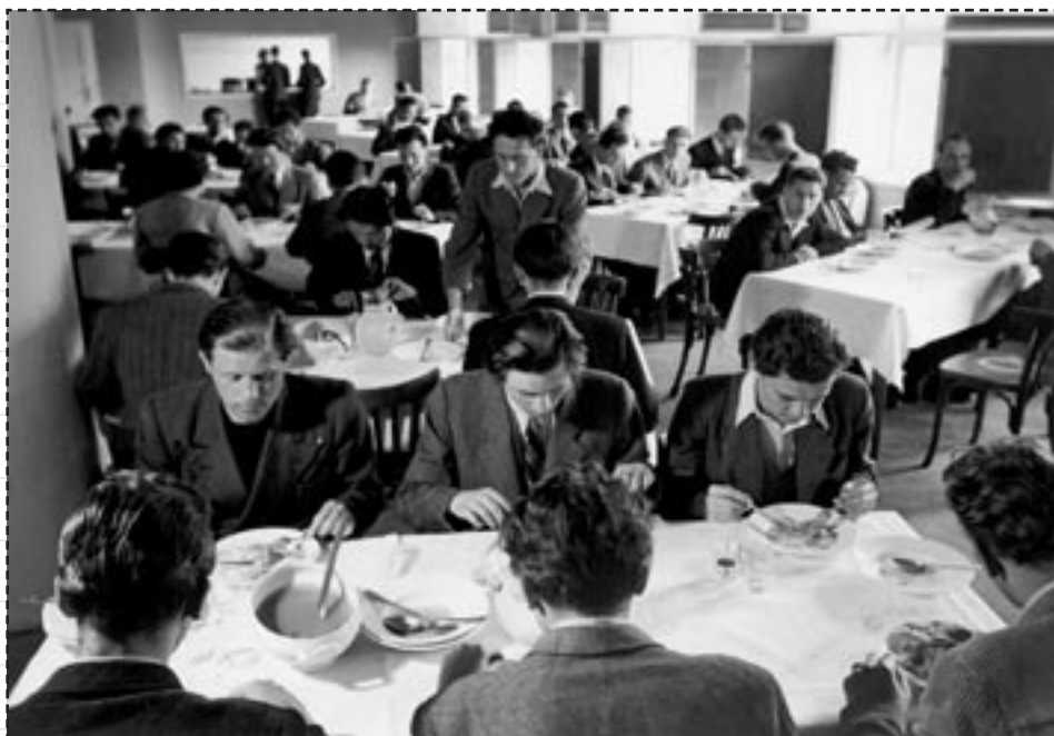
110/ V JÍDELNĚ NA KOLEJI, 1942
